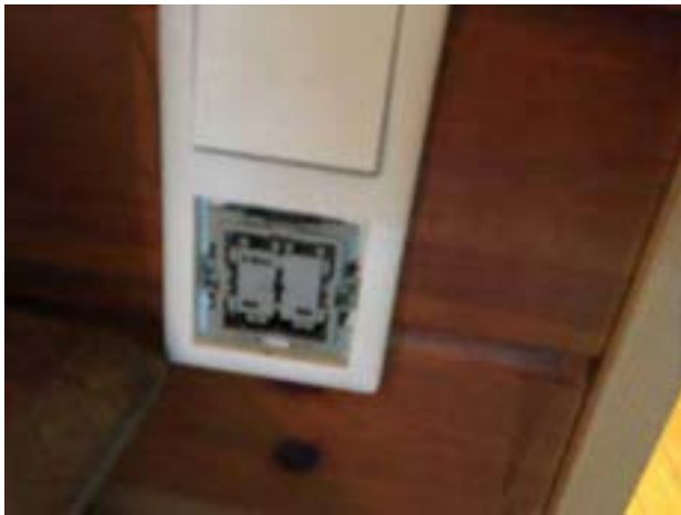
Lichtschakelaars niet volledig afgewerkt.
